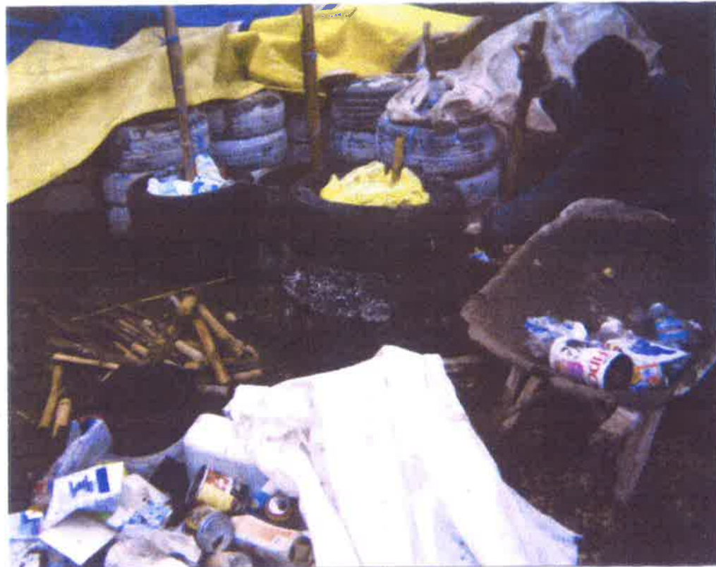
Préparation des cylindres antisismiques.
