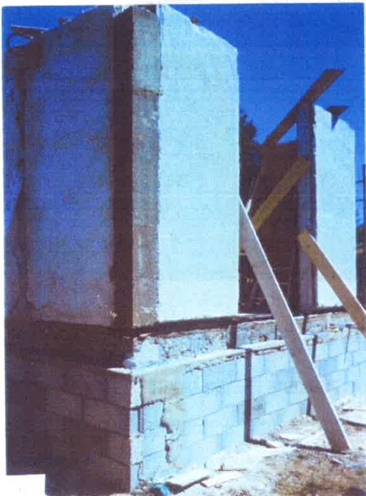
Photo 3 Coffrage des poteaux d'angles en béton. Utiliser des pointes de 100 pour faire la liaison avec les panneaux. Commencer la maison par les angles et fixer des bois
