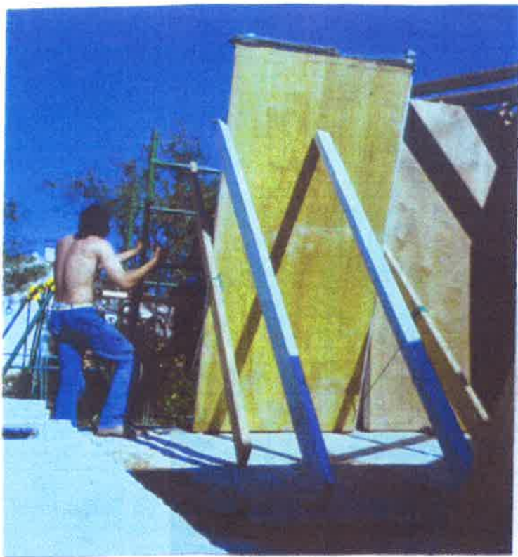
Photo 3 Coffrage des poteaux d'angles en béton. Utiliser des pointes de 100 pour faire la liaison avec les panneaux. Commencer la maison par les angles et fixer des bois
