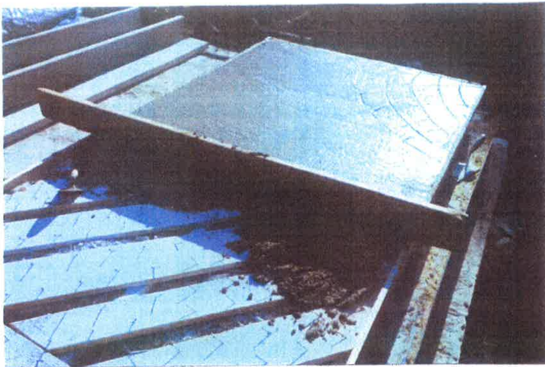
4 du mortier avec de la chaux ou du ciment hydrofuge
