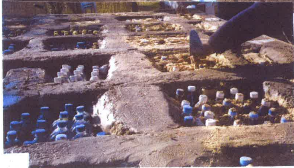
Photo 10 On bourre de sable fin entre les bouteilles jusqu'au goulot.
